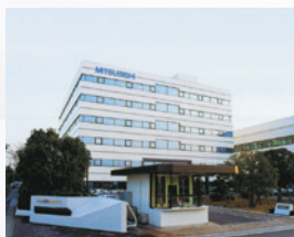
Usine de Shizuoka au Japon
