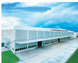
Usine de Chonburi en Thaïlande
