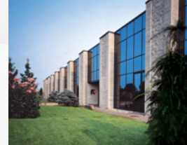
Usine de Pavie : IT Cooling
